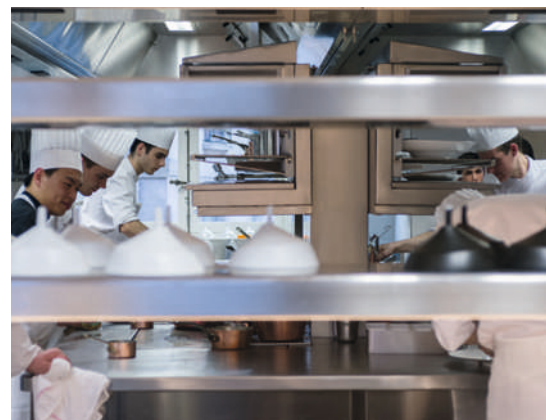
Passerelle avec rampe chauffante d'une hauteur de 1050 mm pour un visuel plus homogène au moment de l'envoi. Aménagement d'un range-plateaux de service.
