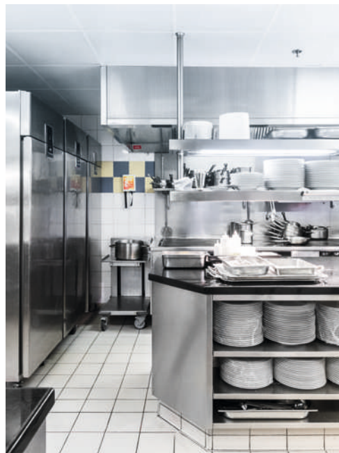
Ensemble de meubles de travail réfrigérés sur-mesure. Meubles réalisés sur socles maçonnés d'une hauteur de 100 mm pour faciliter le nettoyage des sols à grande eau.
