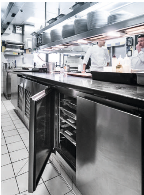
Ensemble de meubles de travail réfrigérés sur-mesure. Meubles réalisés sur socles maçonnés d'une hauteur de 100 mm pour faciliter le nettoyage des sols à grande eau.
